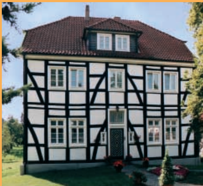
Pfarrhaus Voßwinkel – Fachwerkfassade eines denkmalgeschützten Pfarrhauses in Arnberg – Voßwinkel in traditioneller Bauweise mit Gefachen aus Lehm und Rutengeflecht. Das Gebäude wurde – nach erfolgreicher Bekämpfung eines Messingkäferbefalls – durch das Architekturbüro Simon, 58706 Menden, innen und außen vollständig und originalgetreu modernisiert.
