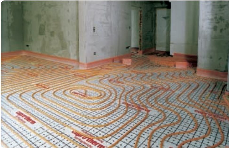
Fußbodenheizung
