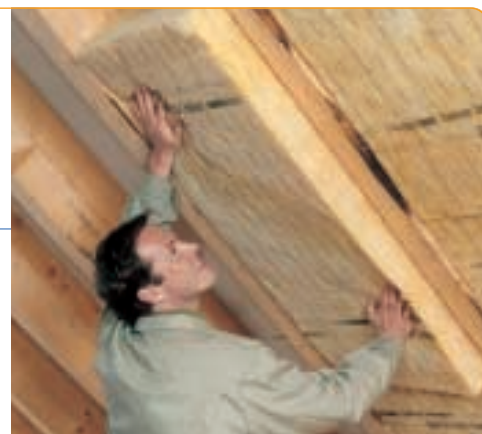
Dämmung Dachschrägen
