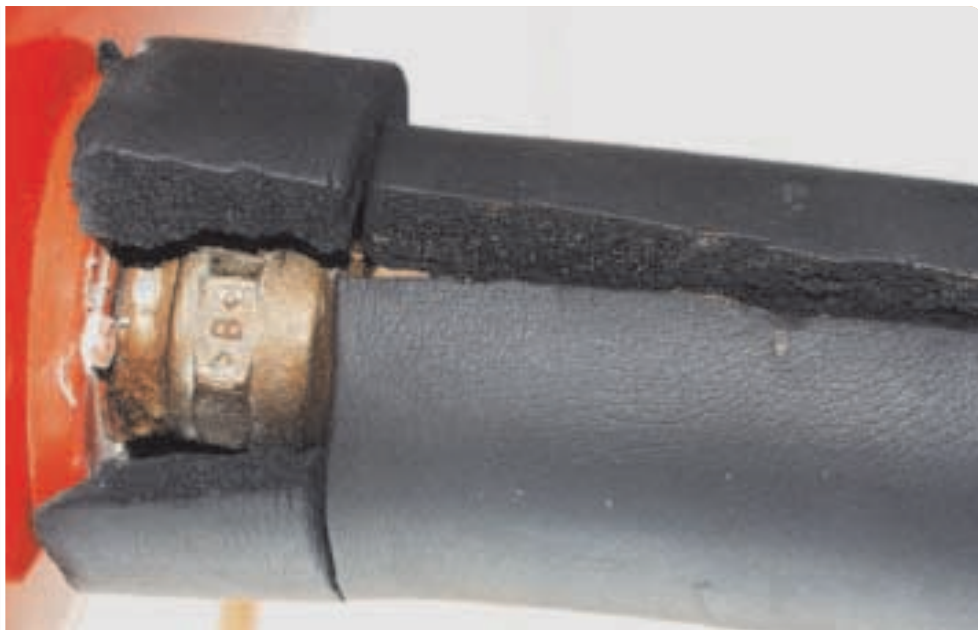
Mangelhafte Rohrdämmung
